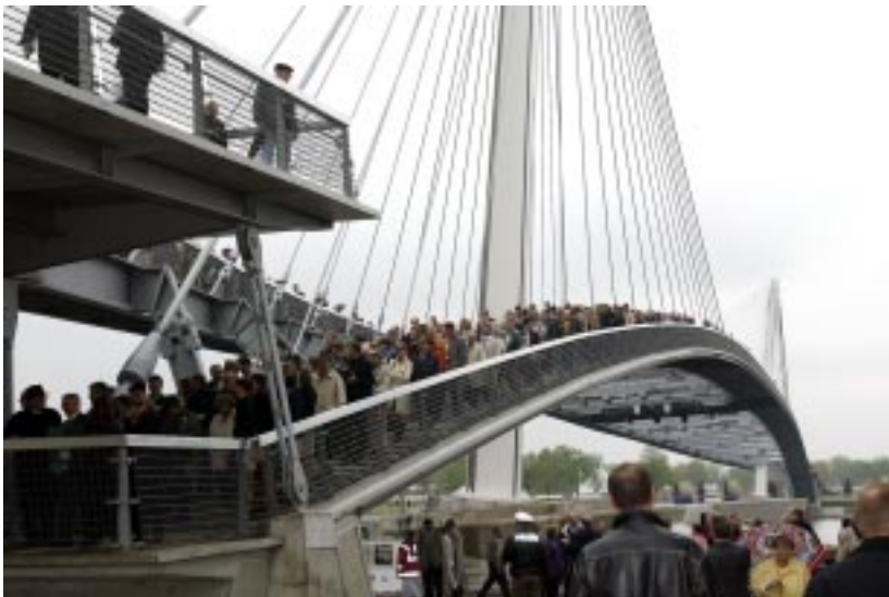
Eröffnung der Mimrambrücke (Bild: Mittelbadische Presse)
