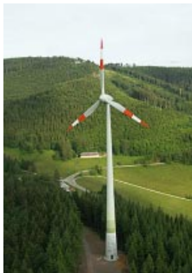
Windrad an der Holzschlägermatte
