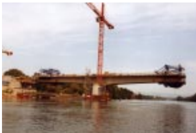
A 861 Rheinbrücke Rheinfelden
