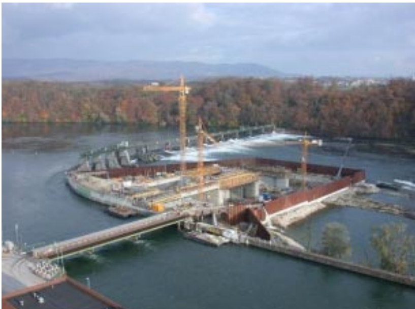
Zwischenausbauzustand (mit neuem Wehr und altem Krafthaus)
