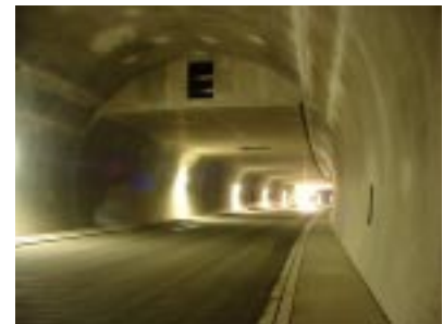
Tunnelrohbau Ortsumfahrung Hornberg
