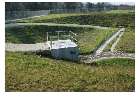
Regenrückhaltebecken L 1161 Ortsumfahrung Bargau
