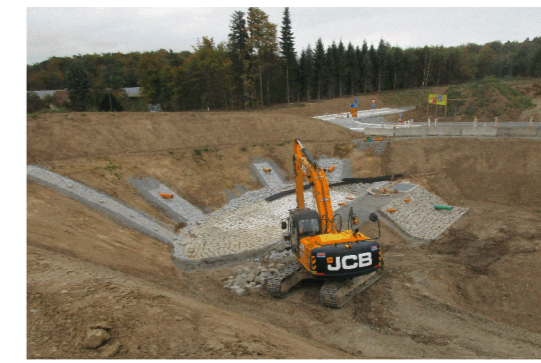
Regenrückhaltebecken Ortsumfahrung Perouse (im Bau)
