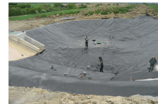
Regenrückhaltebecken K 2576 Schwäbisch Hall (im Bau)
