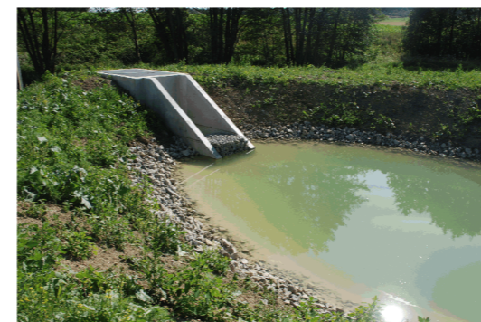
Regenrückhaltebecken K 2576 Schwäbisch Hall
