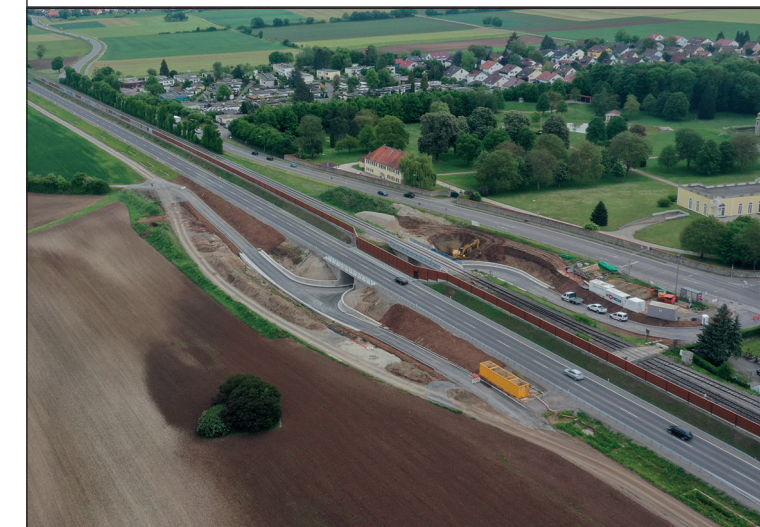
Tübingen-Kilchberg: Bauwerke 7.1/7.2 Unterführung mit LSW
