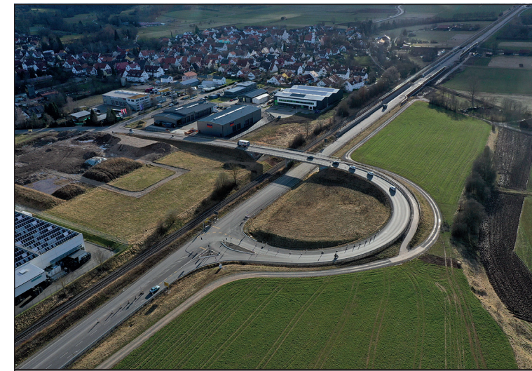
Tübingen-Bühl: Anschluss Bonlanden mit Bauwerk 6.1 und Bühlertalbach
