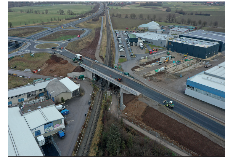
Tübingen-Weilheim: Bauwerk 9.2 über die DB-Strecke
