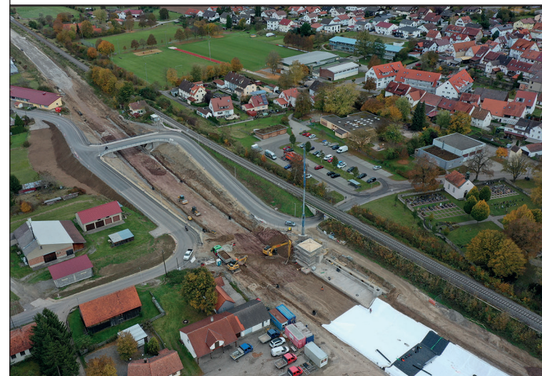
Rottenburg-Kiebingen: Bauwerk 3.1, RRB, Folienwanne
