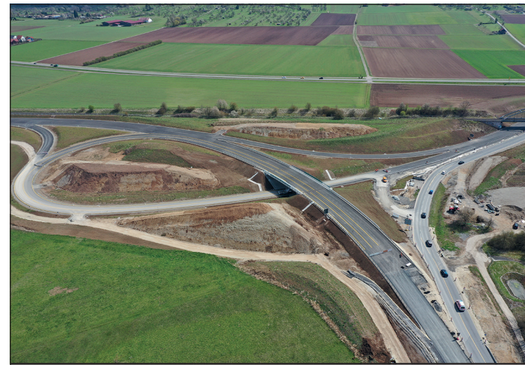
Knoten Rottenburg Ost mit Bauwerk 2.1
