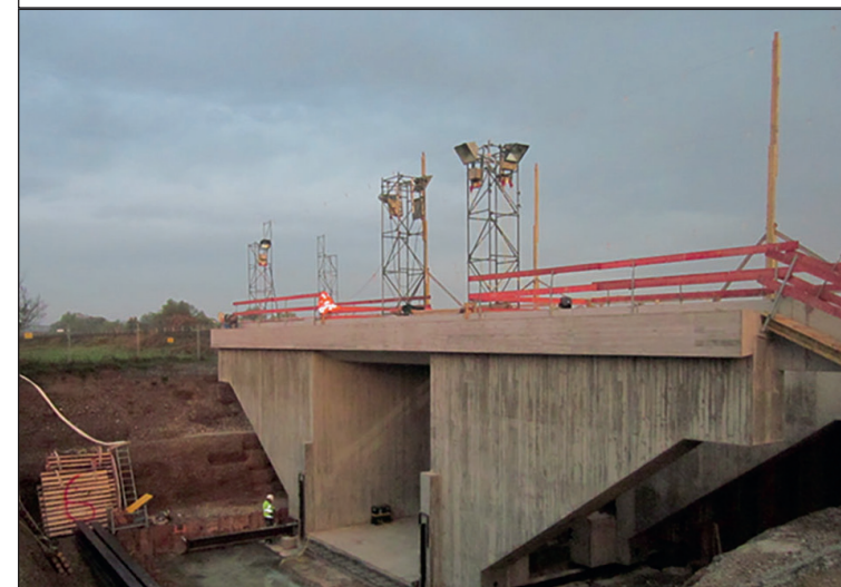
Tübingen-Bühl: Bauwerk 5.1: EÜ vor Einschub
