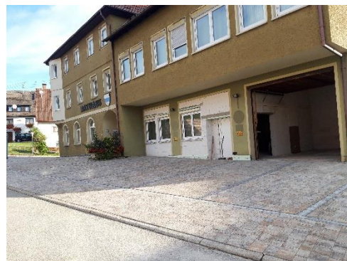
Registraturräume in alten Garagen
