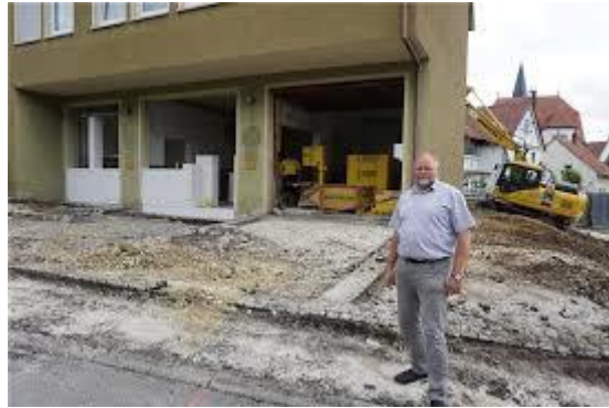
Erste Arbeiten an den Registraturräumen
