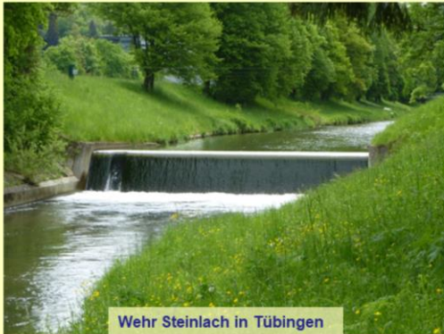
Wehr Steinlach in Tübingen
