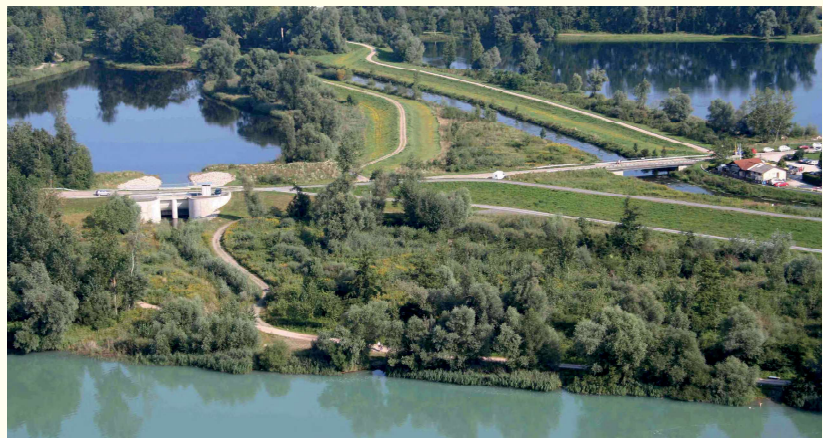
Durchlassbauwerk G von Teilpolder 3 nach Teilpolder 4
