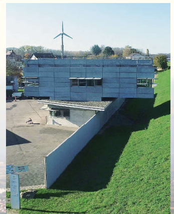
Die Betriebszentrale in Greffern
