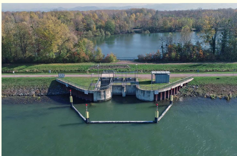
Einlassbauwerk N zum Teilpolder 1
