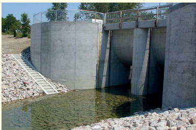
Durchlassbauwerk G Oberwasser Teilpolder 3
