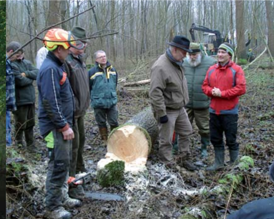
Beginn der Rodungsarbeiten im Januar 2015
