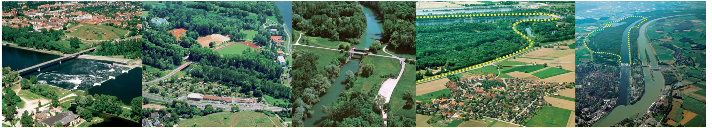
Breisach / Pont de l'Europe / Barrage agricole de Breisach
