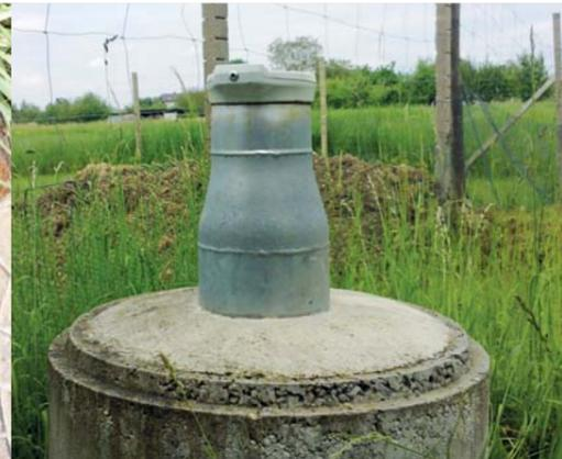
Grundwassermessstelle 4519/067-5 in Kappel mit Pegelrohr über Gelände
