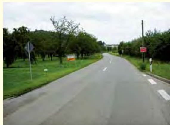
Landesstraße 104 am südlichen Ortsausgang Sasbach
