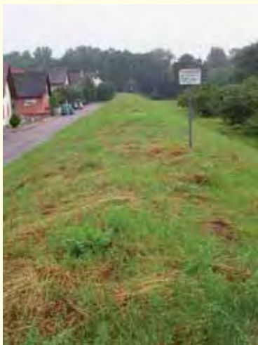
Noch herzustellender Radweg auf der Dammkronen
