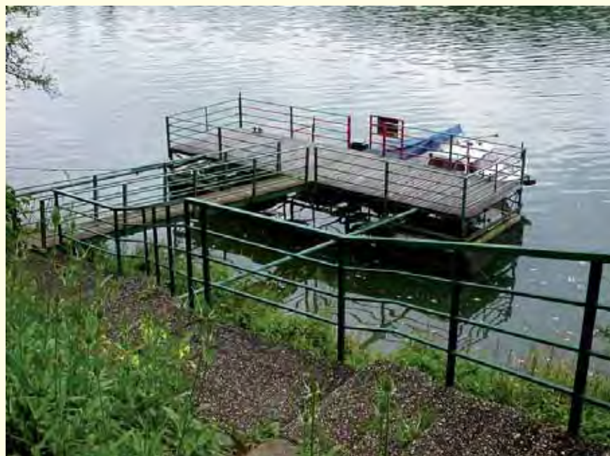
Eine Anlegestelle für Tretboote ist bereits vorhanden.
