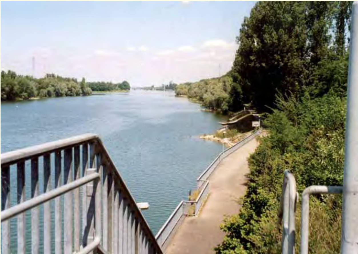
Blick vom Kulturwehr Kehl|Straßburg nach Norden
