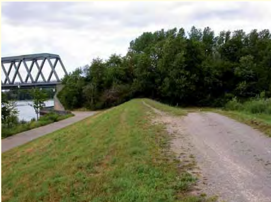
Neue Auffahrt zur Rheinbrücke statt Umweg nach Osten
