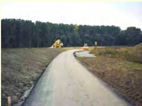
Ausbau des Fahrradweges
