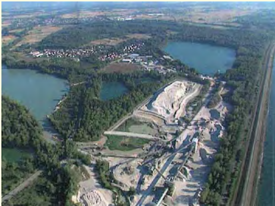
Blick auf das Betriebsgelände „Sehring“
