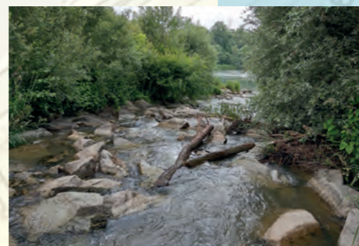
Raue Rampe an der Kanderemündung 2020
