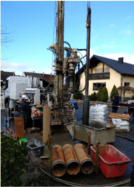
Erkundungsbohrungen und Herstellung einer Grundwasser-Messstelle im Bereich der Tulla-Schule in Dettenheim-Rußheim im Februar 2021 (RP Karlsruhe)
