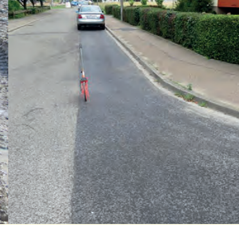
Verschlüsselter Leitungsgraben im innerstädtischen Bereich
