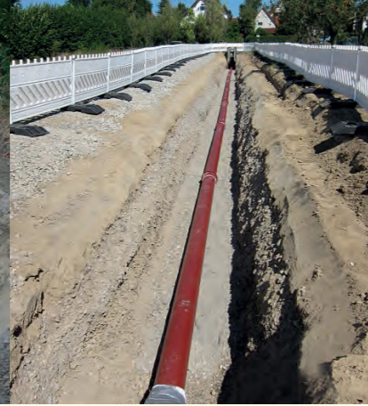
Verlegung der Druckrohrleitung im Graben
