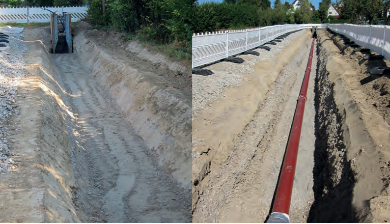
Aushub des Leitungsgrabens
