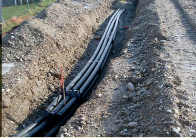
Verlegte Leerrohre für Strom- und Steuerleitungen
