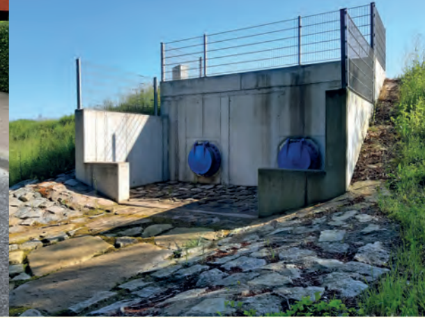
Auslaufbauwerk in den Rückhalteraum
