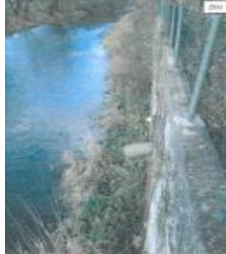
Bild: Zustand nach dem Umbau
