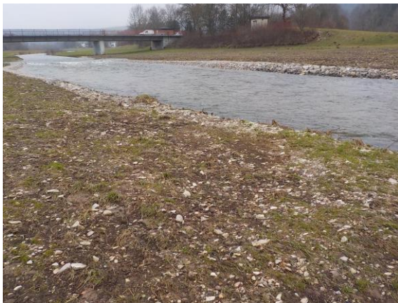
Zustand nach dem Umbau
