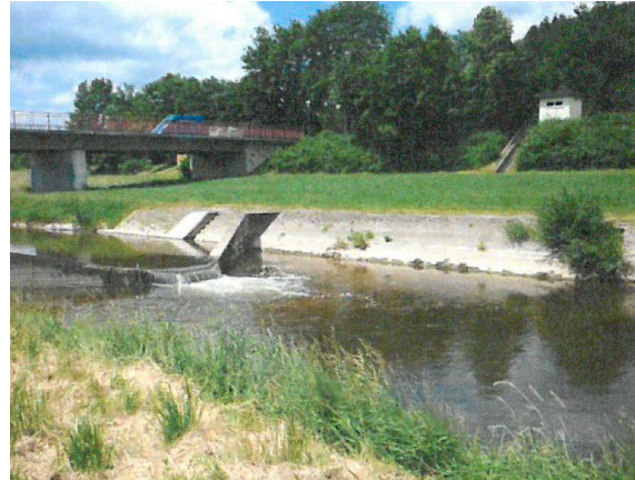
Zustand vor dem Umbau
