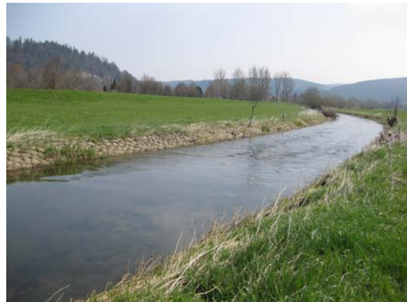
Zustand vor dem Umbau
