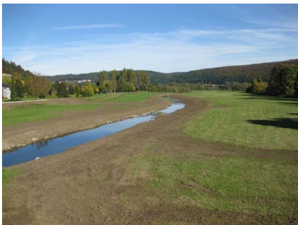
Zustand nach Umbau
