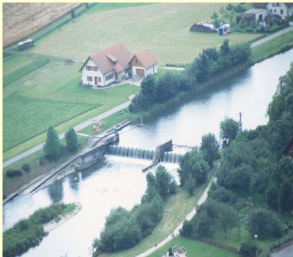
Luftbild vor dem Umbau
