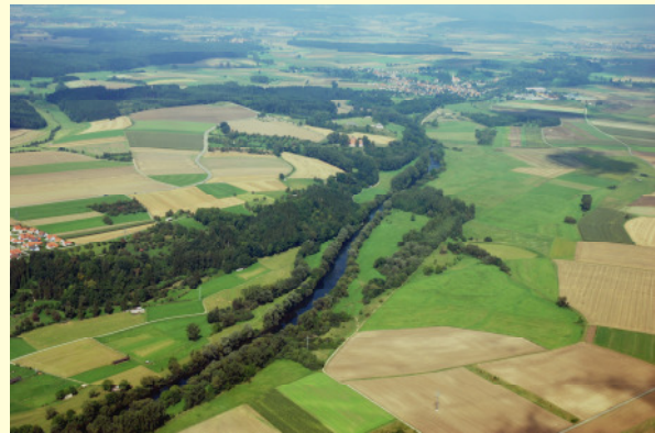
Zustand vor der Sanierung
