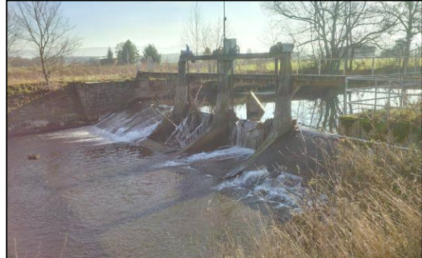
Bild: Zustand vor dem Bau
