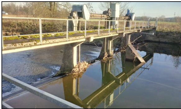
Bild: Zustand vor dem Bau
