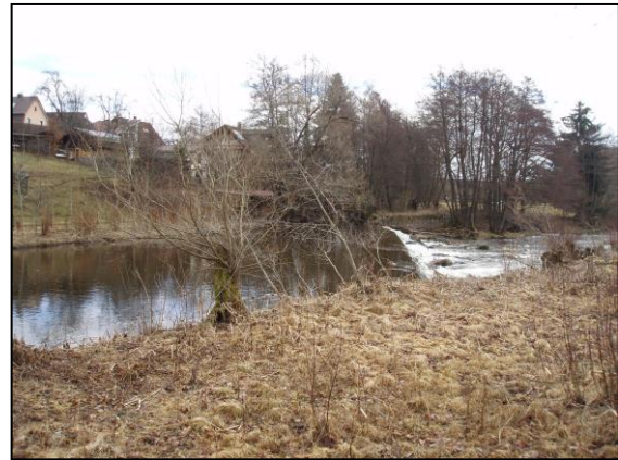
Bild: Zustand vor dem Umbau
