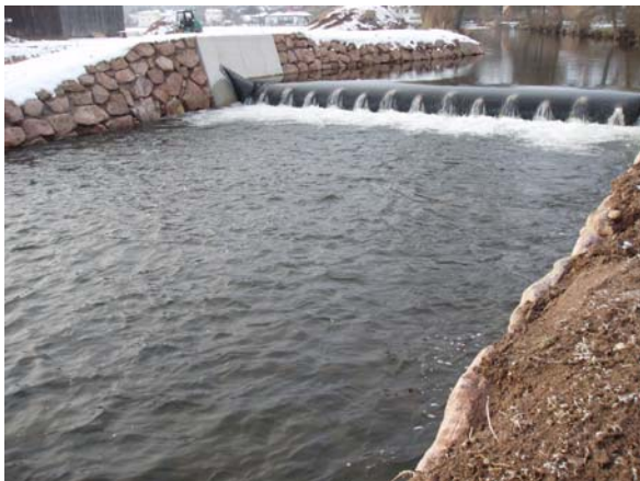
Zustand nach dem Umbau
