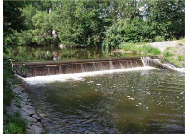
Zustand vor dem Umbau
