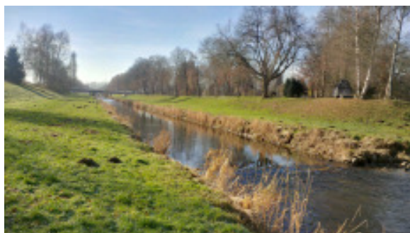
Zustand vor der Sanierung
