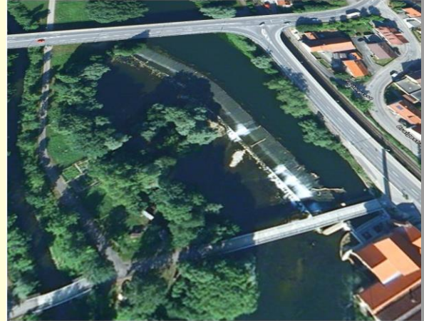
vorheriger Zustand, renovierungsbedürftig
