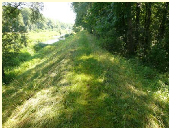
Bild Zustand vor dem Umbau
