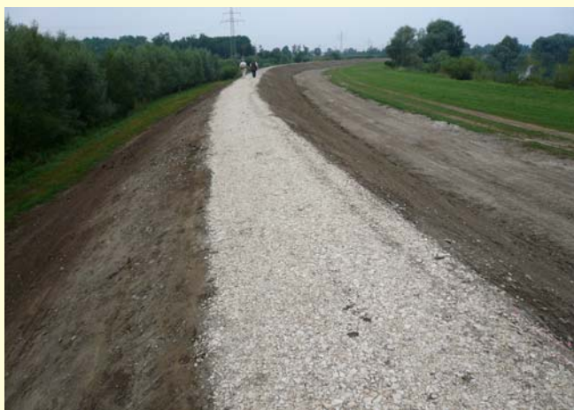
Zustand nach Fertigstellung
