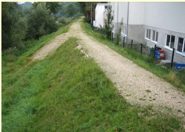
Zustand nach Fertigstellung
