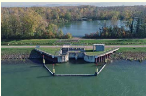
Einlassbauwerk N zum Teilpolder 1
