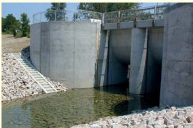
Durchlassbauwerk G Oberwasser Teilpolder 3
