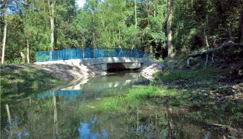
Neue Durchlässe und Brücken
