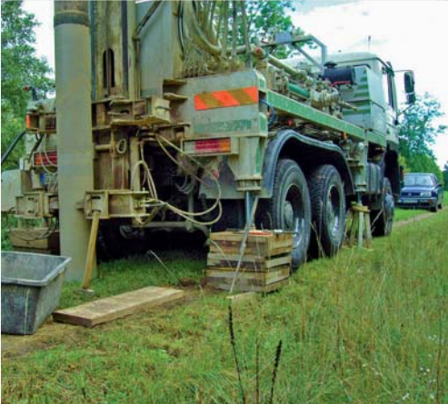
Erkundungsbohrungen liefern weitere Informationen über den Dammbau.
