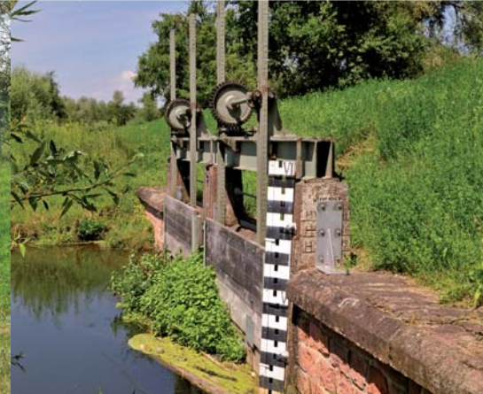
Die Einlaufschleuse in den Mühlbach liegt im Hochwasserdamm.
