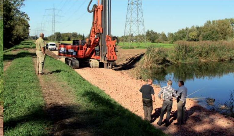
Einbringen einer Spundwand für den Dammverteidigungsweg mit angrenzendem Mühlbach
