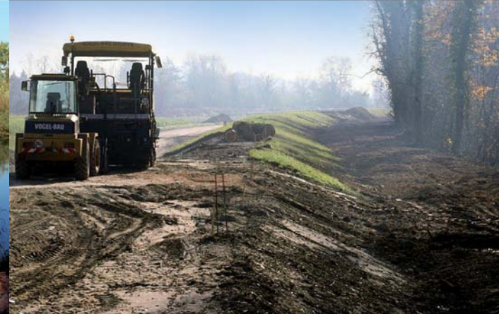
Arbeiten am Hochwasserdamm mit Blick von der L 100 nach Süden
