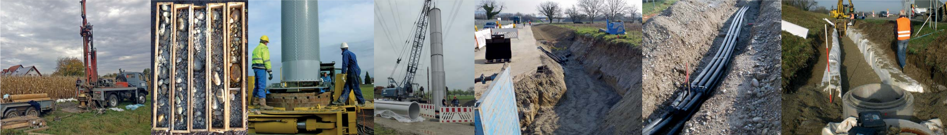
Kernbohrungen Bodenproben (tiefigestaffelt) Brunnenbohrung und -ausbau Brunnenbau Leitungsbau Leerrohre für Strom- und Steuerleitungen Teilgefüllter Leitungsraben mit Verbau
