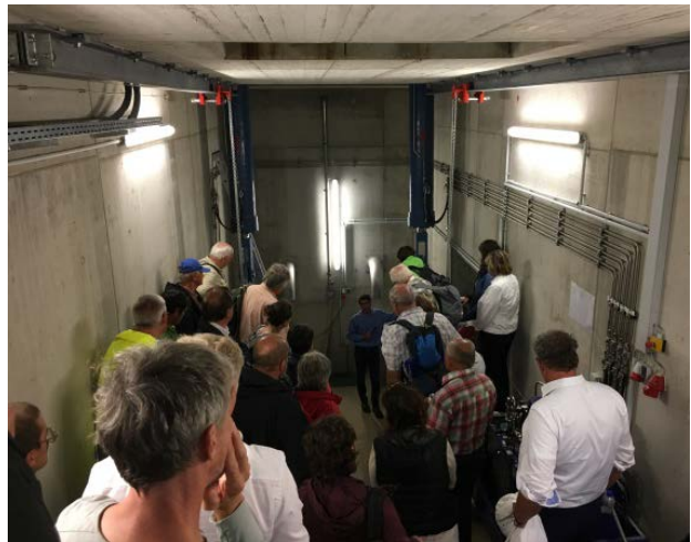
Abb. 15: Besichtigung des Ein-/ Auslassbauwerks
