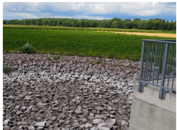
Abb. 17: Blick auf den befestigten Bereich des Ein-/Auslassbauwerks in den Rückhalteraum
