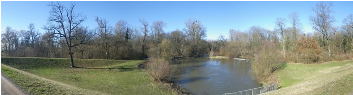
Abb.29: Blick vom Durchlassbauwerk in die Aue
