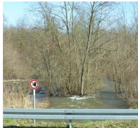
Abb. 20: Bauwerk M12 - Überflutungen im Polder Söllingen/Greffern
