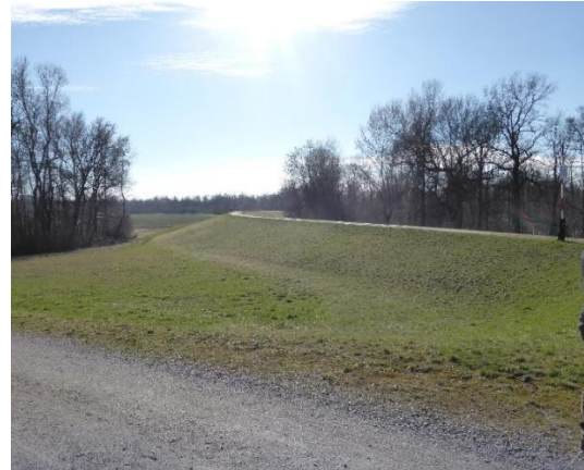
Abb. 22: Trenndamm der Polder Altenheim
