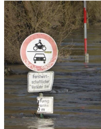
Abb. 4: Überflutete Brücke in Au am Rhein
