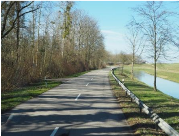
Abb. 9: Fahrt durch den Teilpolder IV des Polders Söllingen/Greffern
