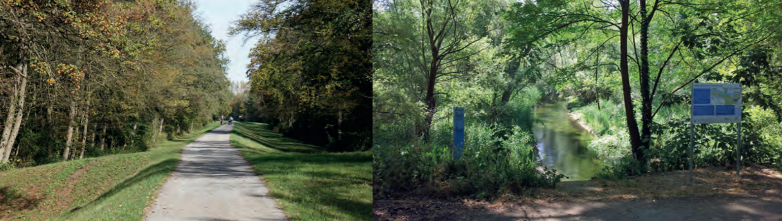
Der Rheinhochwasserdamm XXV wird ertüchtigt
