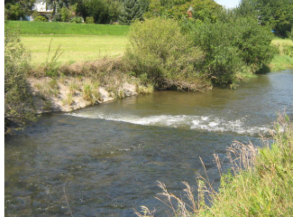
Zustand vor dem Umbau
