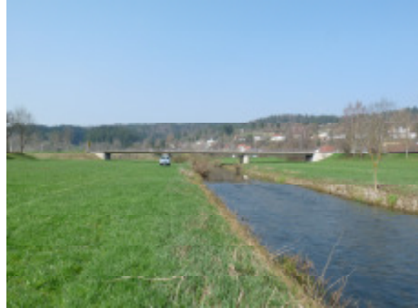
Bild Zustand vor dem Umbau
