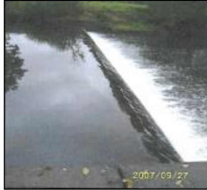
Bild: Zustand vor dem Abbau
