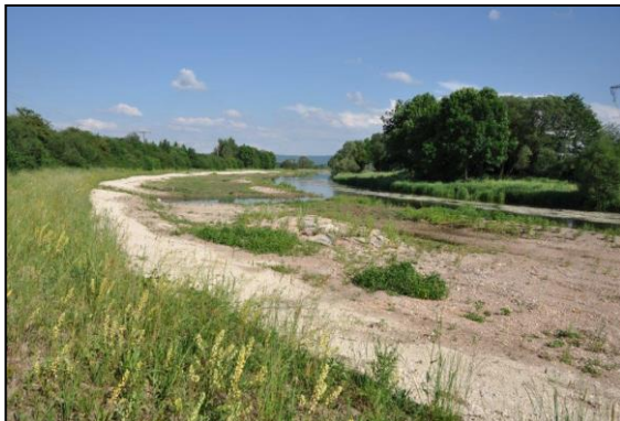
Bild: Zustand nach dem Umbau
