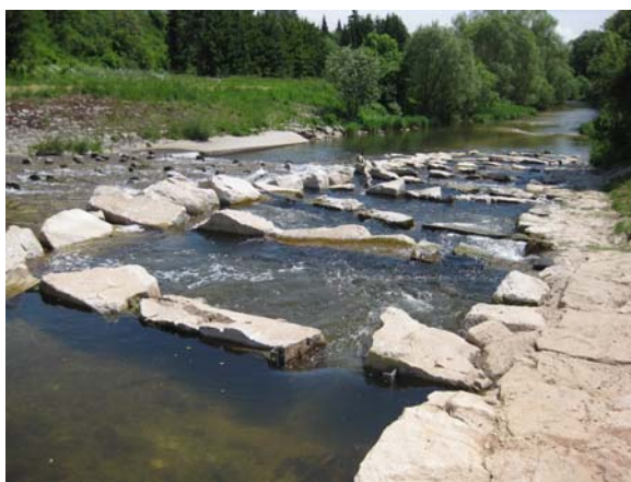
Zustand nach dem Umbau
