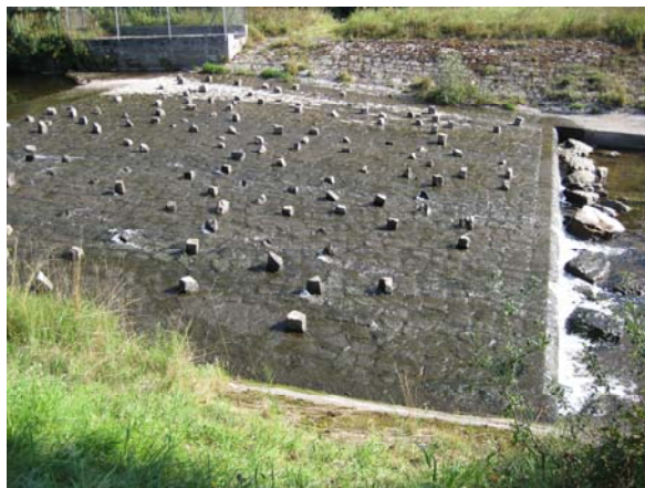
Zustand vor dem Umbau
