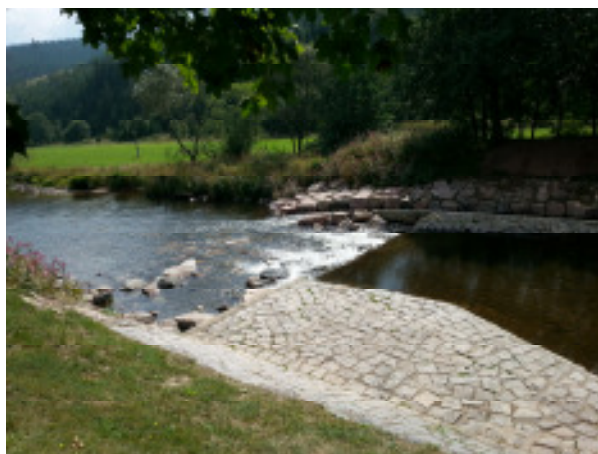
Bild Zustand nach dem Umbau
