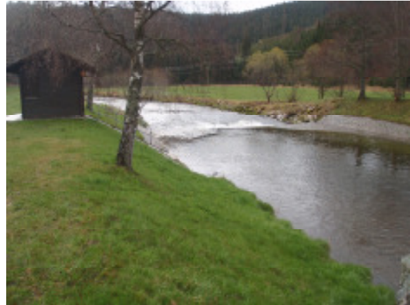
Bild Zustand vor dem Umbau
