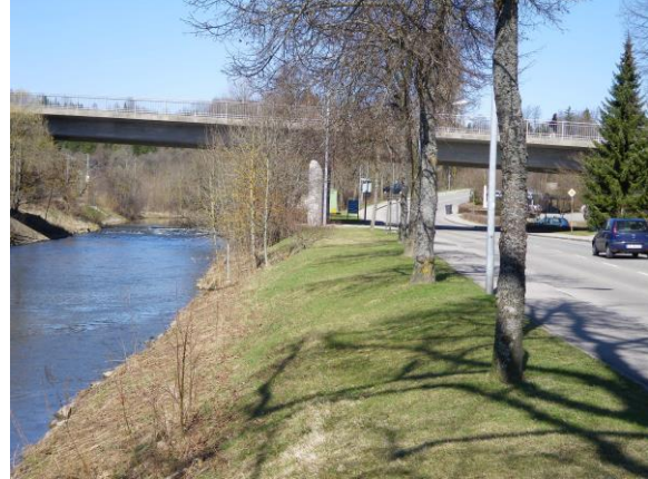
Bild Zustand vor dem Umbau
