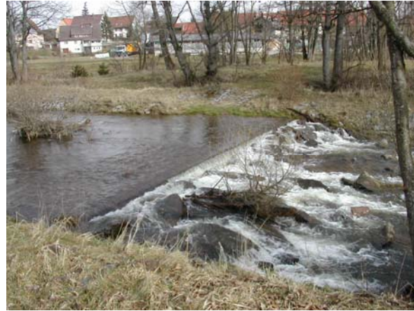
Zustand vor dem Umbau
