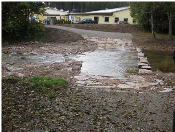
Zustand nach dem Umbau
