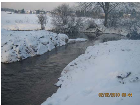
Zustand nach dem Umbau
