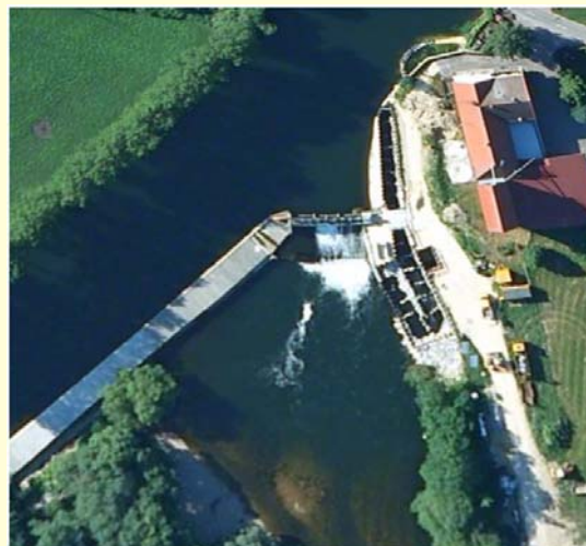
Zustand im Bau
