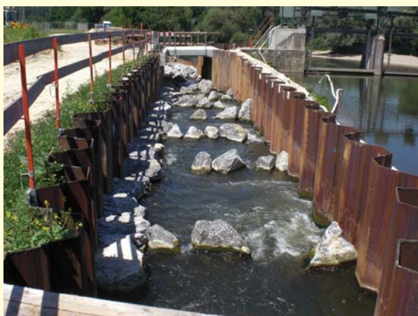
Fischpass im Bau
