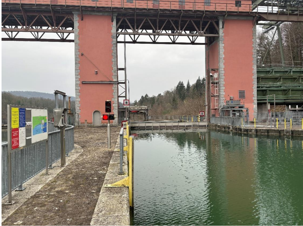
Einfahrt Schleuse Oberwasser
