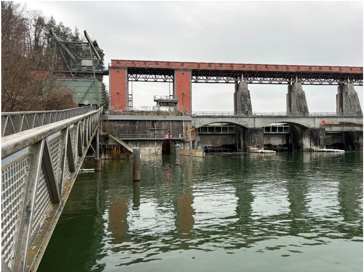
Einfahrt Schleuse Unterwasser
