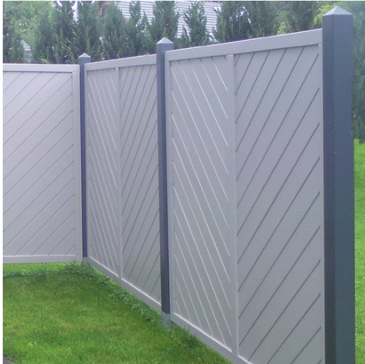
Abbildung 10 Praxisbeispiele von Sichtschutz-Elementen mit an sich gutem Schallschutzpotential, allerdings reduziert der Bodenspalt die akustische Wirkung merklich.
