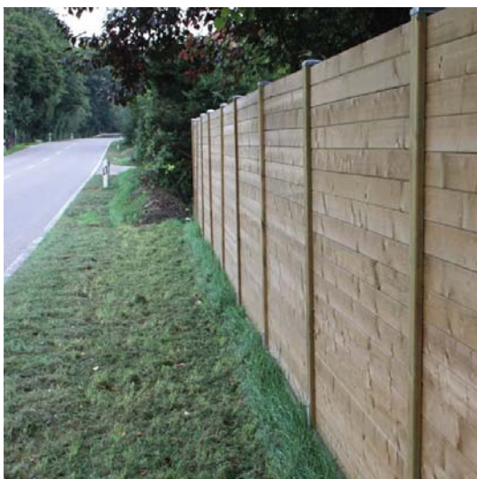
Abbildung 8 Praxisbeispiele von Sichtschutz-Elementen aus Holz in ansprechendem Design aber mit typischen akustischen Undichtigkeiten zwischen den Latten und im Bereich der Pfosten. Die aufwendige Abdichtung beeinflusst auch das Erscheinungsbild.
