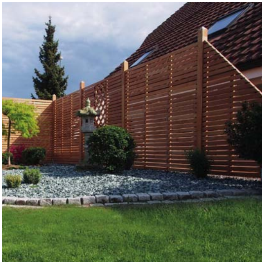
Abbildung 8 Praxisbeispiele von Sichtschutz-Elementen aus Holz in ansprechendem Design aber mit typischen akustischen Undichtigkeiten zwischen den Latten und im Bereich der Pfosten. Die aufwendige Abdichtung beeinflusst auch das Erscheinungsbild.
