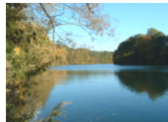
Restwasserstrecke des Kraftwerks Rheinau: oberer Hilfsstau (Foto: H.J. Wetzlar)
