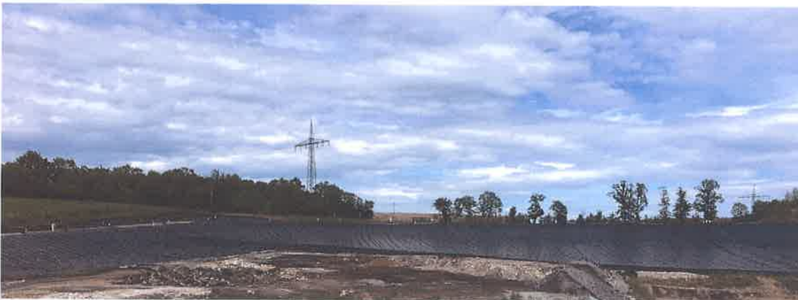
Abbildung 11: Verfüllabschnitte VA X und VA XI (Folienabdeckung).
